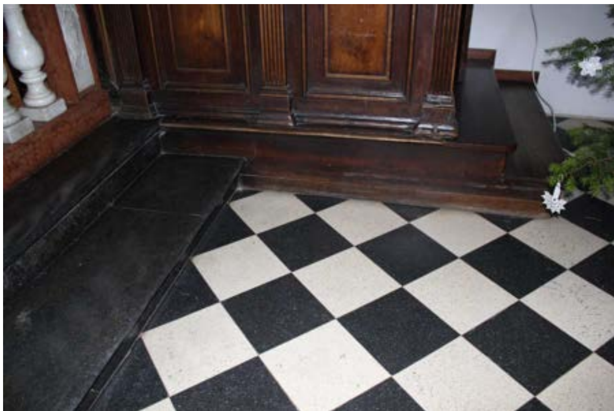
Fot. 29. Wtórna posadzka nawy głównej wykonana z płyt lastryko, widoczne istniejące stopnie do prezbiterium z marmuru szwedzkiego, widok na stalle i drewniane stopnice.
