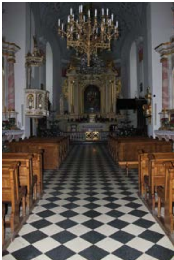
Fot. 23. Wtórna posadzka nawy głównej wykonana z płyt lastryko, widok na ołtarz główny.
