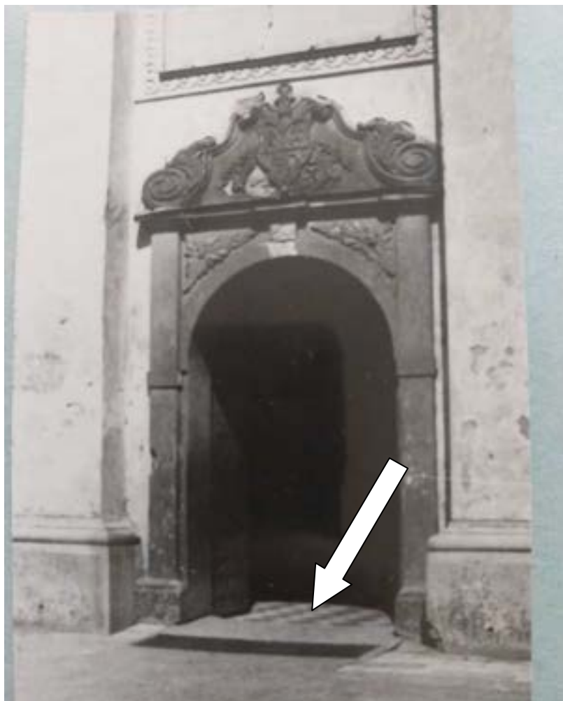
Fot. 14. Posadzka wejścia do kruchty, zdjęcie z 1955 roku, widoczna posadzka w szachownicy. Źródło: Archiwum LWKZ delegatura w Radzynie Podlaskim.
