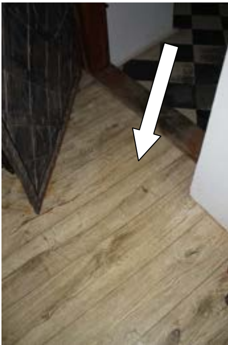
Fot. 20. Posadzka z wylewki betonowej, linoleum, pom. 0.3, stan na 2023 rok.
