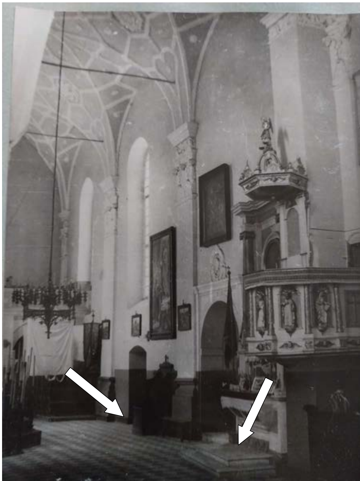
Fot. 16. Posadzka w nawie głównej, stan na 1955 rok, widoczne cokoliki przyścienne oraz nieistniejące stopnie do ołtarzy bocznych. Źródło: Archiwum LWKZ delegatura w Radzynie Podlaskim
