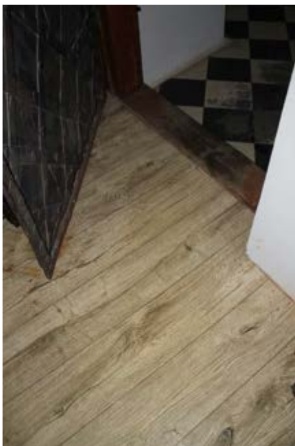
Fot. 33. Posadzka betonowa w przedsionku wyłożona linoleum.
