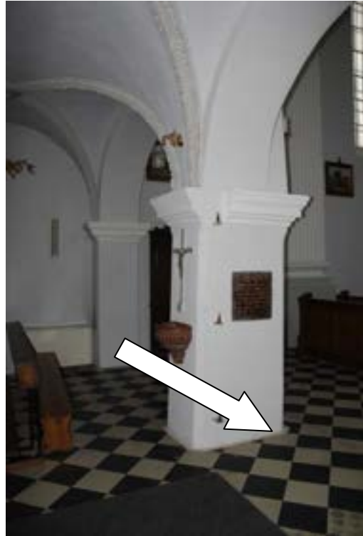
Fot. 19. Posadzka z lastryko, widoczny pas pozostały po zdemontowanym cokoliku, stan na 2023 rok.
