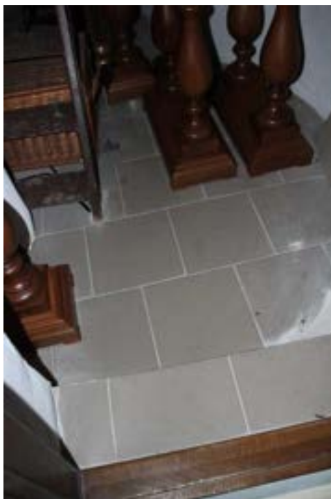
Fot. 22. Posadzka z gresu technicznego, pom. 0.10, stan na 2023 rok.
