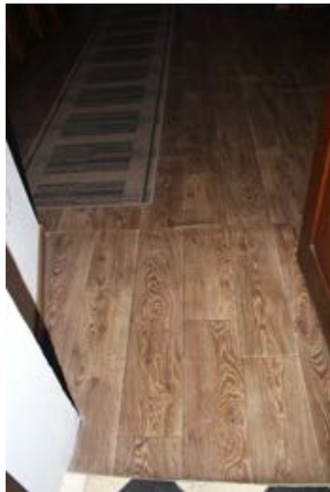
Fot. 21. Posadzka z wylewki betonowej, linoleum, pom. 0.7, stan na 2023 rok.
