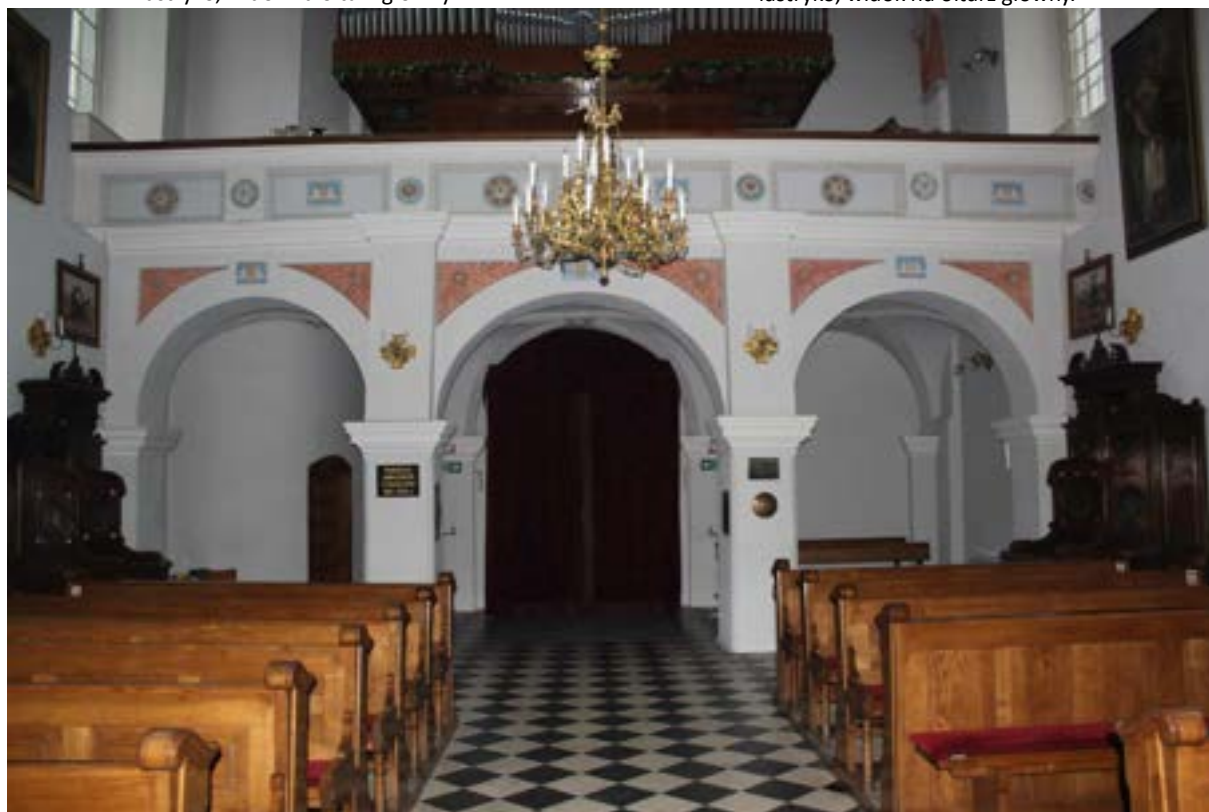
Fot. 25. Wtórna posadzka nawy głównej wykonana z płyt lastryko, widok na chór.
