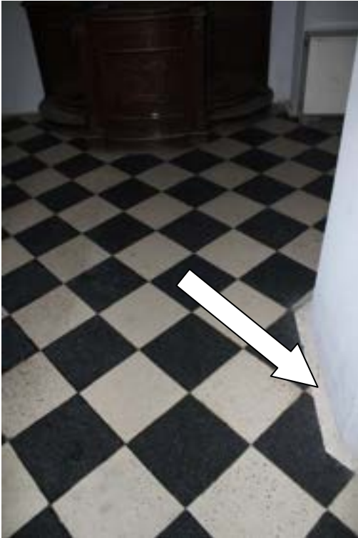
Fot. 18. Posadzka z lastryko, widoczny pas pozostały po zdemontowanym cokoliku, stan na 2023 rok.
