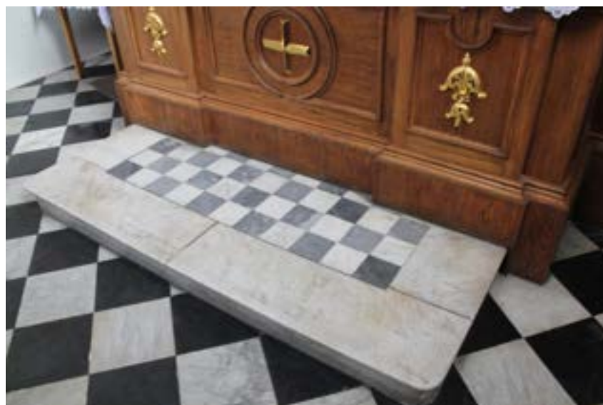
Fot. 13. Posadzka kaplicy bocznej Pana Jezusa, stan na 2023 rok.
